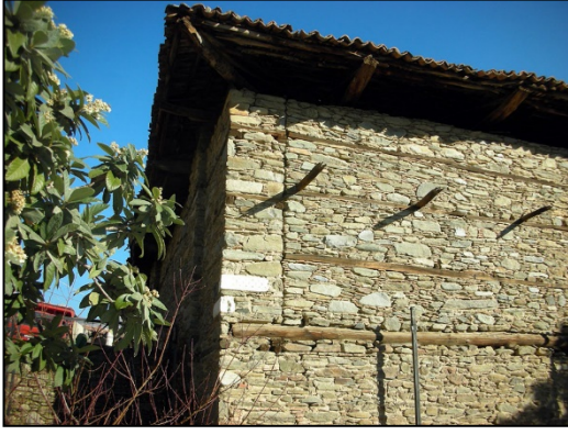
Figure 20. A house in Birgi, (Foto: Dışkaya, H.)
