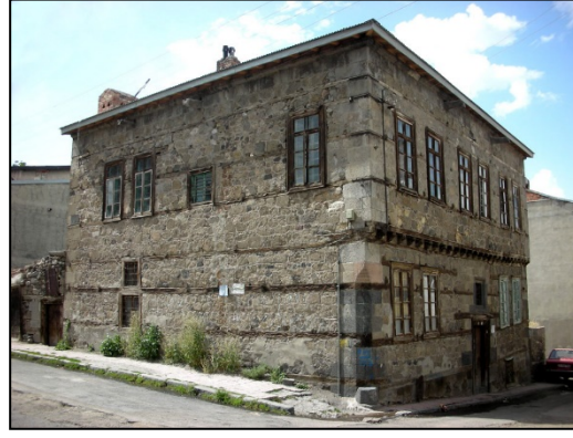
Figure 21. A house in Erzurum, (Foto: Dışkaya, H.)
